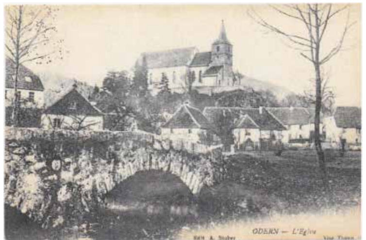
Le pont du Sutterley avant sa destruction.
