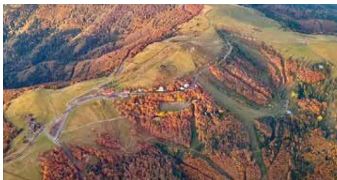
Vue aérienne du Markstein après démolition du grand Hôtel Touristra Photo : M. FELTZINGER
