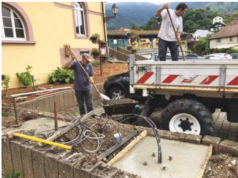
Mise en place du panneau interactif
