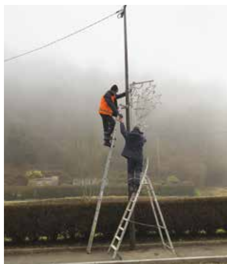
Mise en place de l'éclairage de Noël
