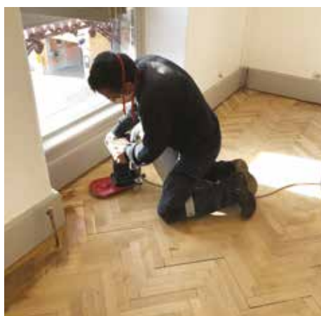
Réfection d'un parquet dans un appartement communal
