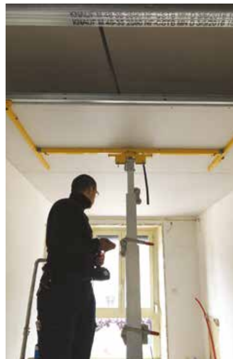
Pose d'un plafond
