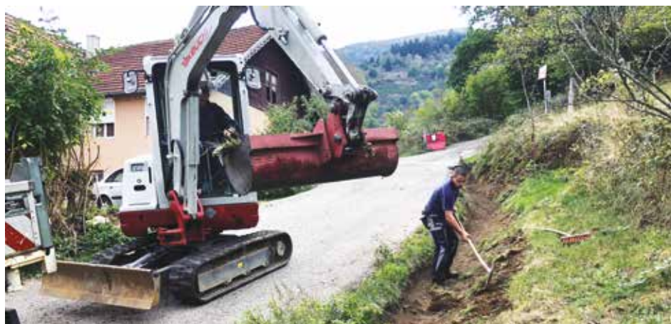
Curage d'un fossé
