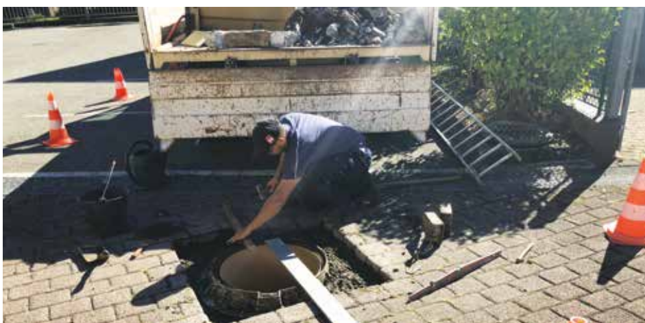
Mise à niveau d'un regard d'assainissement
