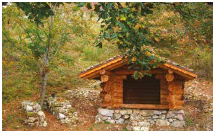
Construction d'un soubassement en pierre sèche pour « l'abri du berger » - Sentier des tilleuls
