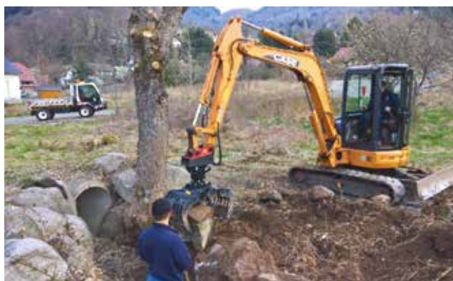
Enrochement & nettoyage des berges du Hensbachruntz en régie.
