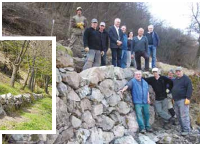
Construction d'un soubassement en pierre sèche pour « l'abri du berger » - Sentier des tilleuls
