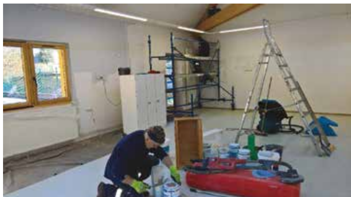
Rénovation de la salle multifonction en régie
