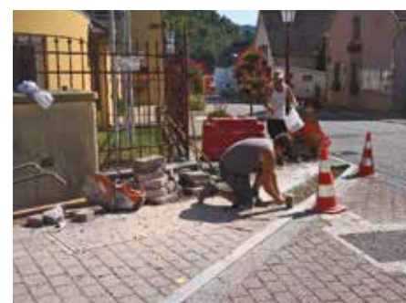
Réaménagement de la sortie des écoles et du parking du 1 rue Durrenbach par l'entreprise Royer Frères pour être en conformité avec la réglementation pour les personnes à mobilité réduite.
