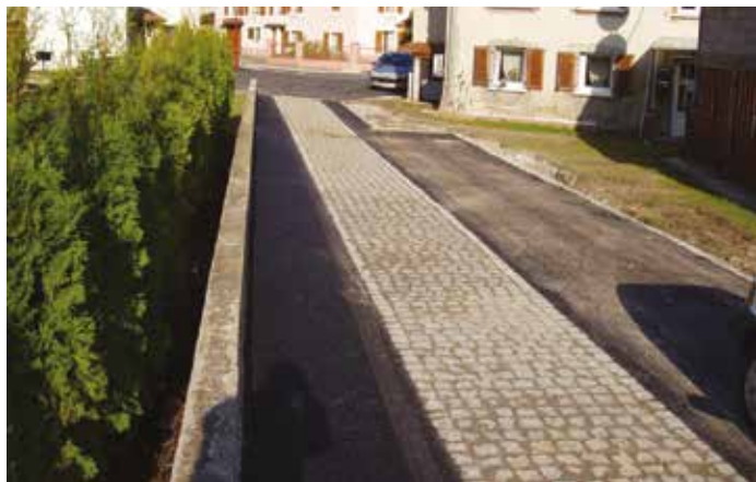
Réalisation d'une allée pavée – rue Gorth Accès ruisseau pédagogique
